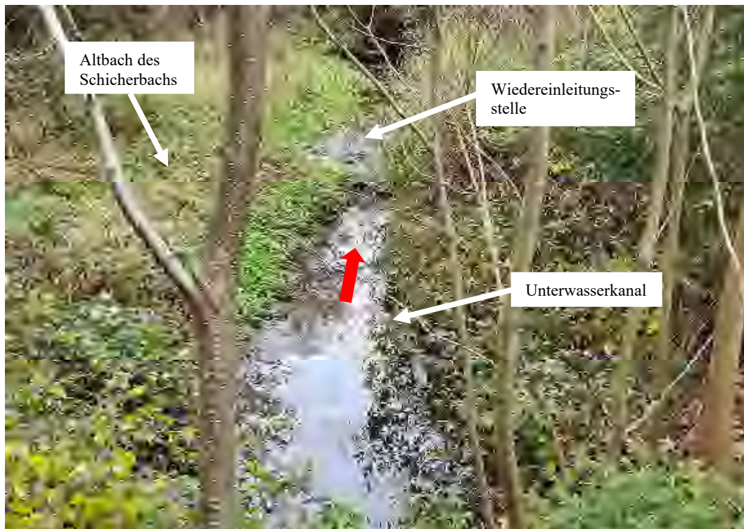
Bild 5.5: Unterwasserkanal und Wiedereinleitungsstelle
