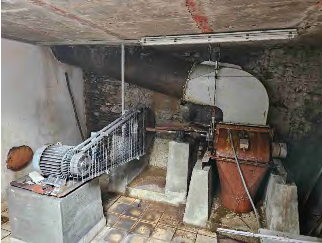
Bild 5.4: Kraftraum mit Turbine und Generator
